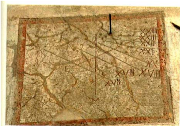
Un altro quadrante in stato di avanzato degrado. Si trova a Piverone, in Via Flecchia 88, e risale al 1850. L'indicazione è a ore italiane con stilo normale rispetto alla parete; da notare le linee equinoziale (E) e meridiana (M).
