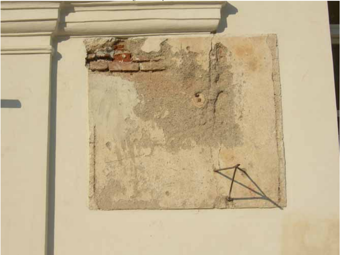
Immagine scattata prima del consolidamento
