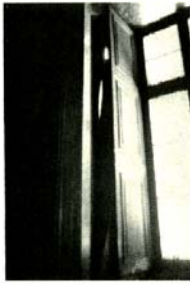
Fig. 3-26a Torino, Palazzo Reale: Fessura Meridiana nel Salone degli Svizzeri. Nella figura si vede il taglio nel marmo della finestra e l'orma luminosa che comincia ad apparire.
